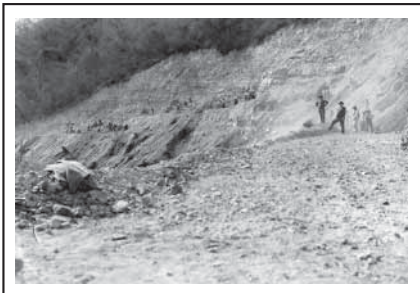
Migrantes croatas trabajando en la construcción del ferrocarril C14 (Gentileza, Ing. María Elena Toncovich)
