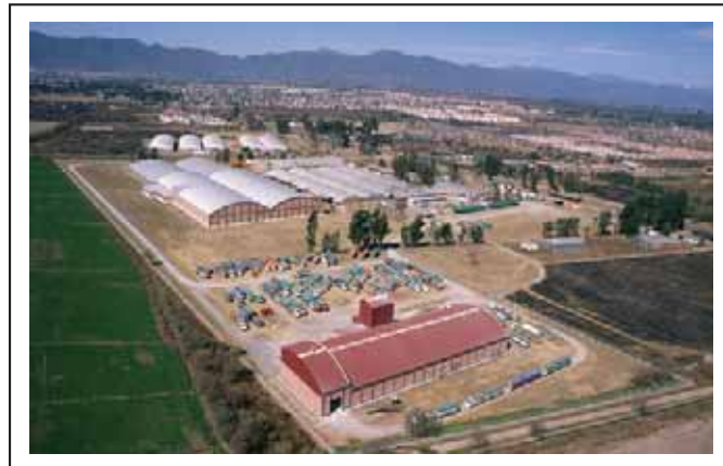
■ Vista de planta de la COPROTAB en el año 2010.
